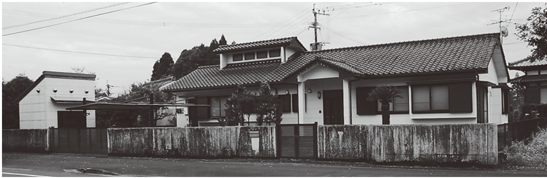
▲空室となっている医師住宅（並木）
