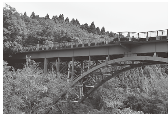
▲橋梁補修事業（神武大橋）
