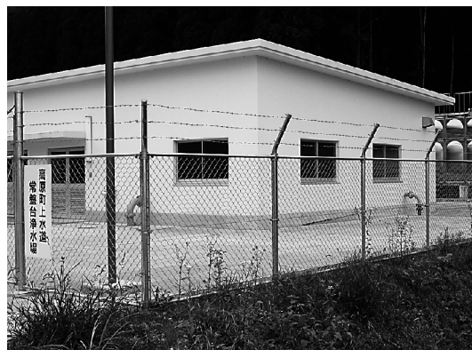
高原町上水道 常盤台浄水場
