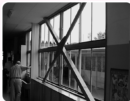
学校地震補強工事
