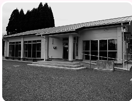
常盤台活性化センター
