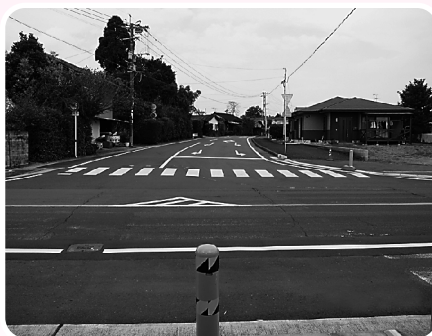
拡幅された町道
