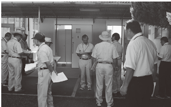
▲狭野小学校（教職員トイレ改修工事）
