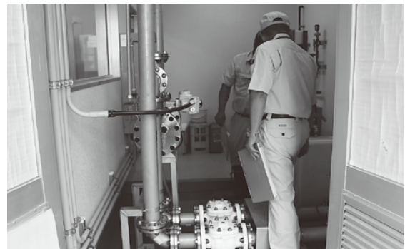
▲旭台地区（紫外線処理施設整備工事）
