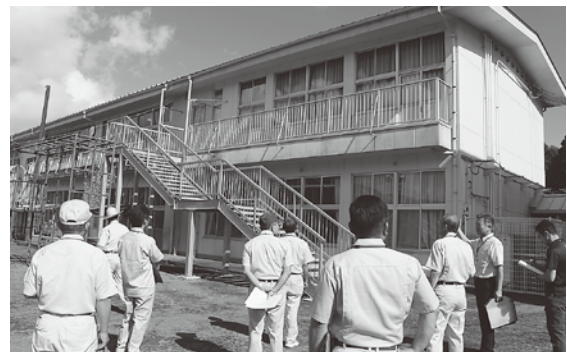
▲狭野小学校（非常階段設置・屋根改修工事）
