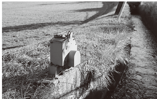
▲土地改良区が維持管理している水路
