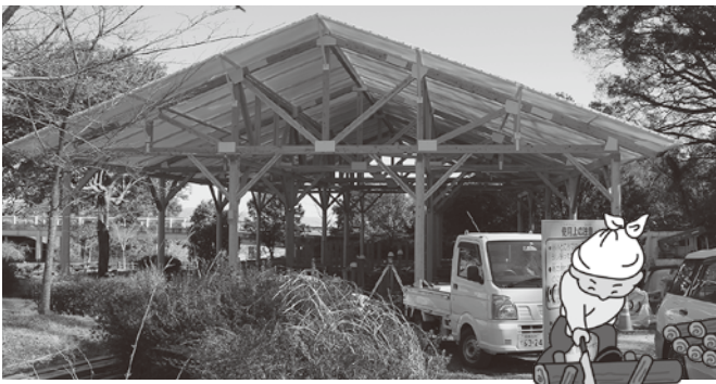
▲大型木製遊具施設建設中
