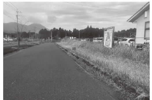
▲工業団地内の道路脇の未舗装部分
