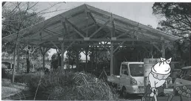
▲大型木製遊具施設建設中
