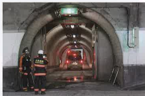
高速道路上下線を繋ぐ連絡坑
