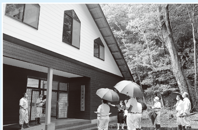
▲御池松の港野営場施設改修工事
