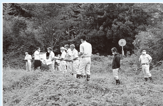
▲温水平地区排水工事
