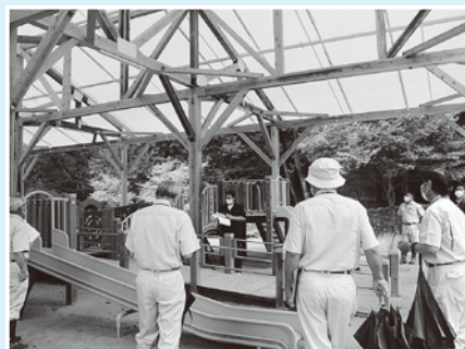
▲皇子原公園大型木製遊具建設工事
