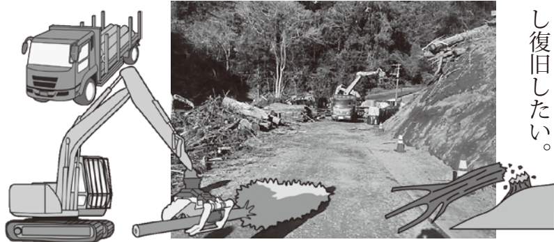
▲水源施設の復旧作業
