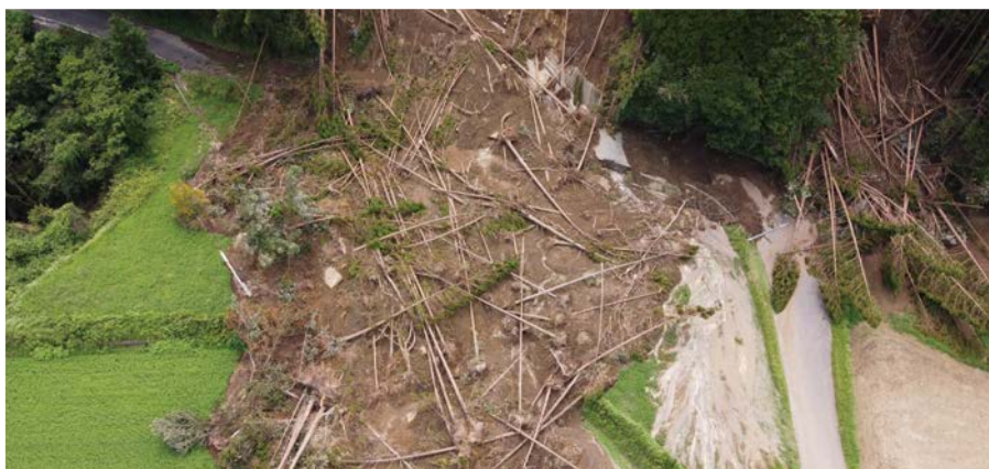
▲ 柳野岩内線の山林崩壊
