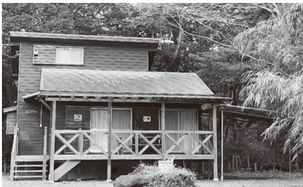
皇子原公園コテージ改修工事
