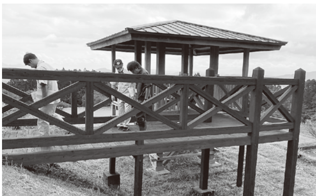
皇子原公園あずまや改修工事
