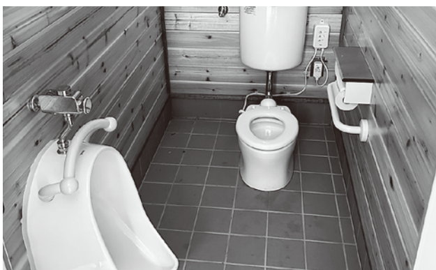
皇子原公園公衆トイレ工事
