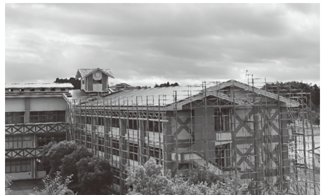
高原中学校校舎屋根補修工事
