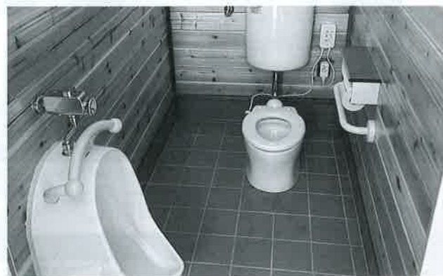
皇子原公園公衆トイレ改修工事
