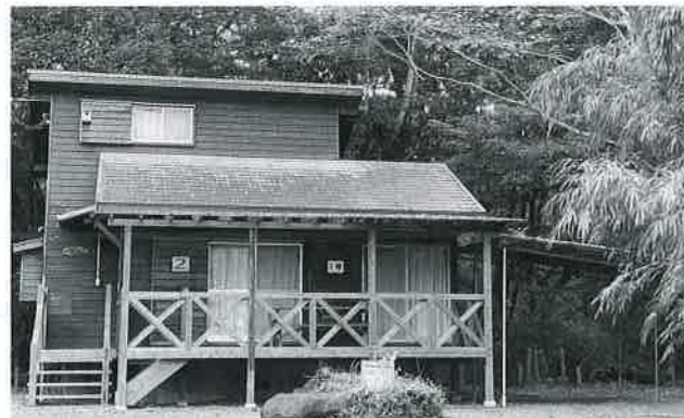
皇子原公園コテージ改修工事
