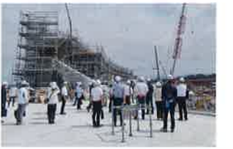
新宮崎県陸上競技場(都城市)
