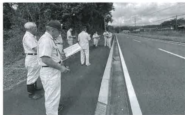
並木旭台線工事
