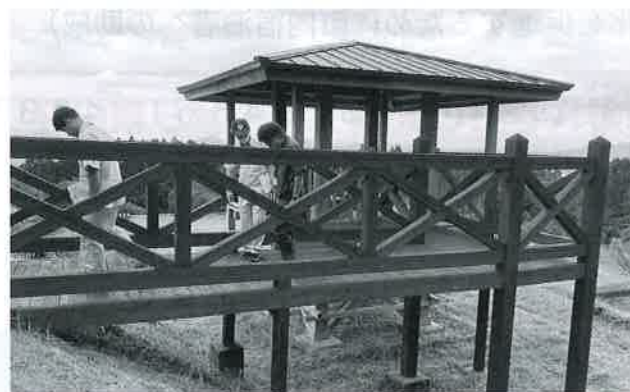
皇子原公園あずまや改修工事
