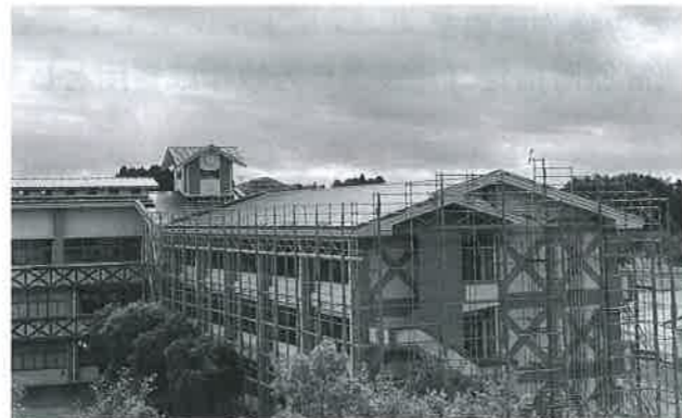
高原中学校校舎屋根補修工事
