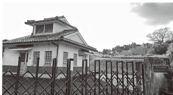
広原北部地区農業集落排水処理場
