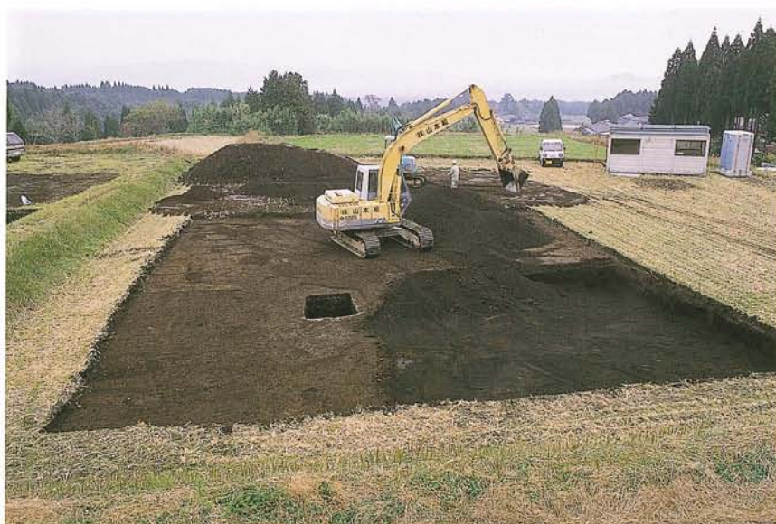
D区表土掘削状况
