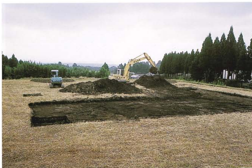
F区表土掘削状況
