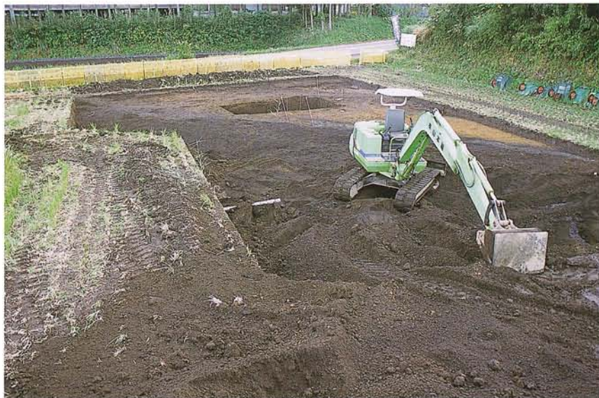
H区表土掘削状況
