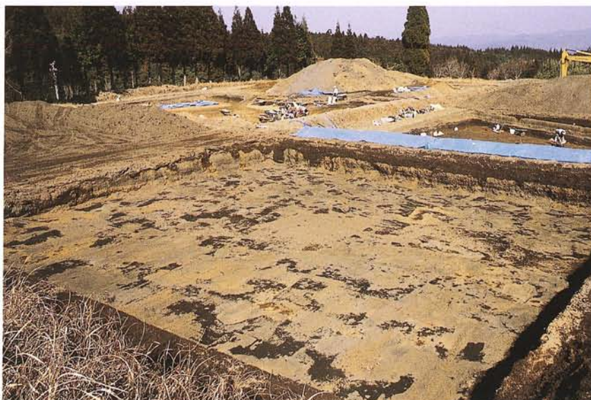
B 2 区表土除去状況
