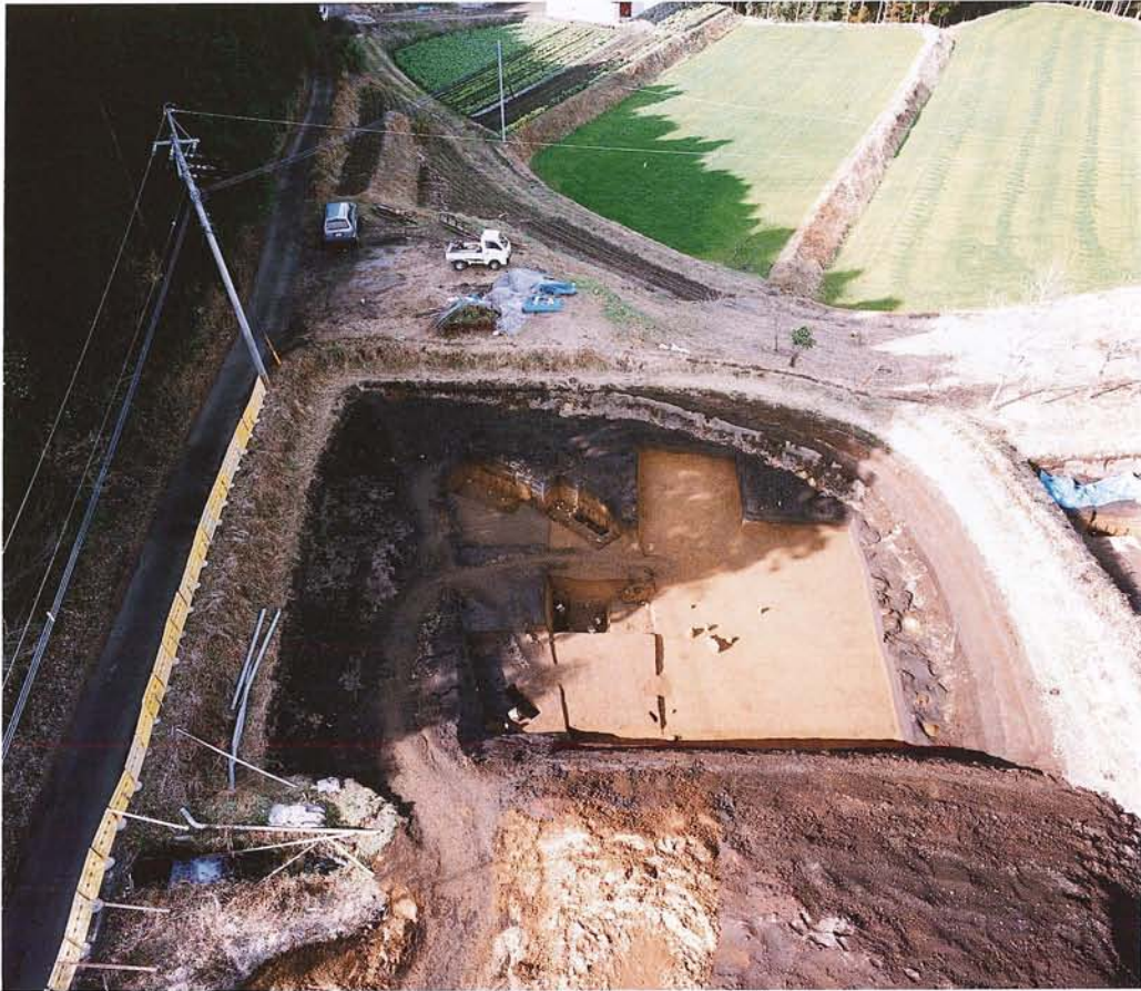
A区 全景(完掘状況)
