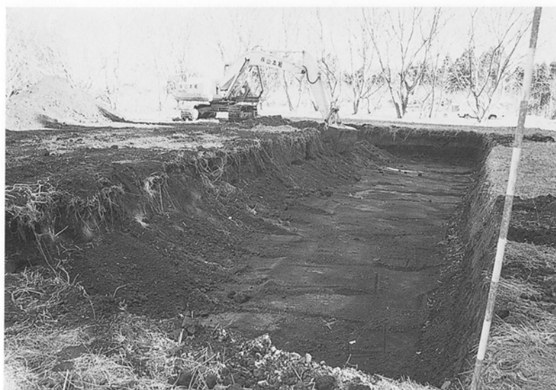
30. B区表土掘削状況
