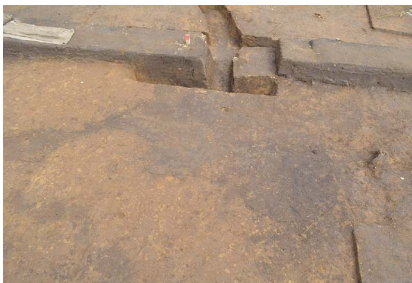
SA 2 SI 10 検出状況 西より
