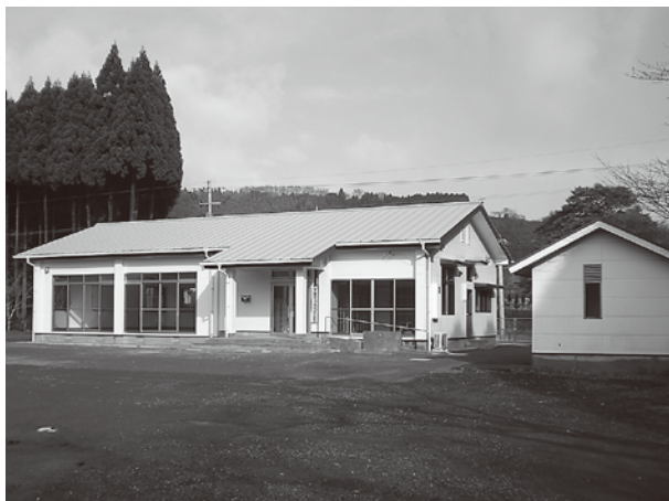
▲常盤台活性化センター
