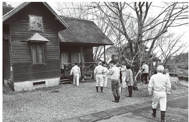
▲皇子原公園コテージC棟改修工事 120万円 ※テラス改修工事
