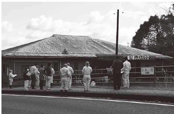
▲皇子原公園レストハウス改修工事 1,200万円 ※屋根及び室内改修工事
