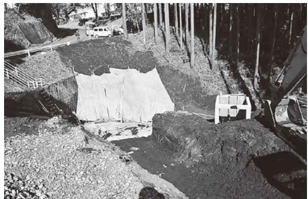
▲町道改良事業霧島団地高校線 2,460万円 ※施工延長 L=114.0m
