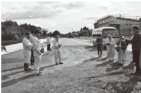
▲街路整備二葉・村移(3事業合計) 4,500万円 ※施工延長 L=80.0m他
