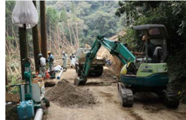
仮設道路、導水管敷設工事の状況
