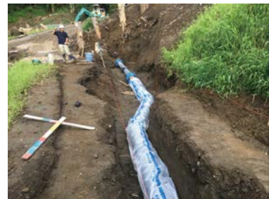
導水管の敷設（復旧工事）の状況
