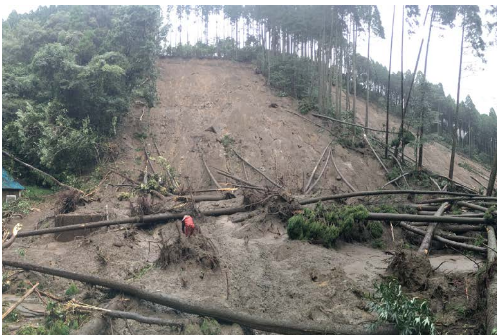
災害発生直後の常盤台水源地
