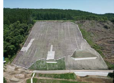
治山事業・町道復旧工事完了（業者提供）
