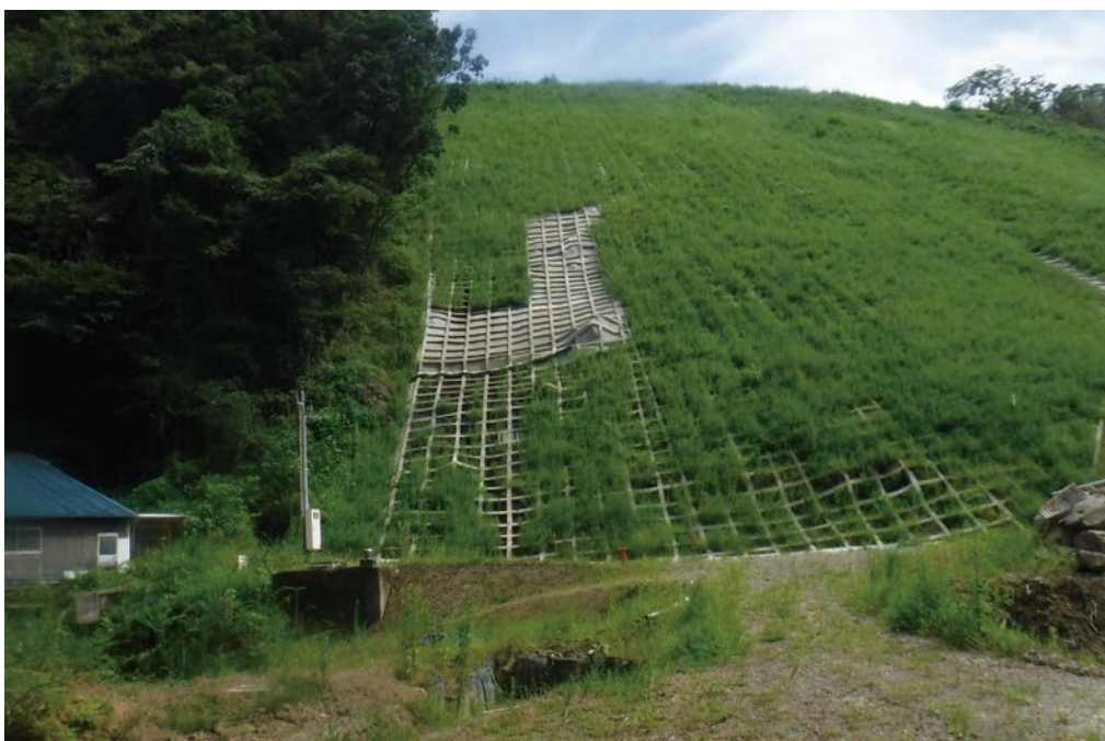
現在の常盤台水源地（左下の青い屋根が水源建屋）
