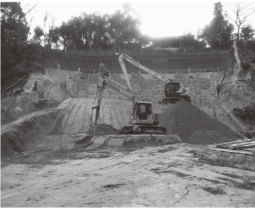
▲災害復旧工事(中入木6号線)
