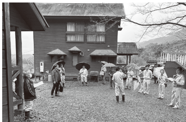
▲皇子原公園 コテージ改修工事
