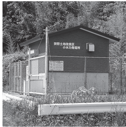
▲小水力発電発電所
