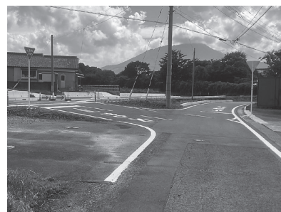
▲街路整備事業 二葉・村移線の取付道路
