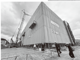
▲津久見市庁舎建設現場
