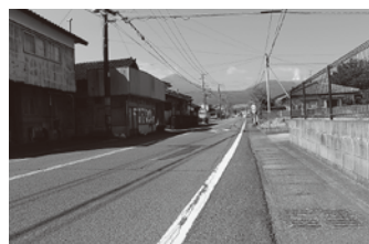
▲舗装補修事業（単独）二葉・並木線
