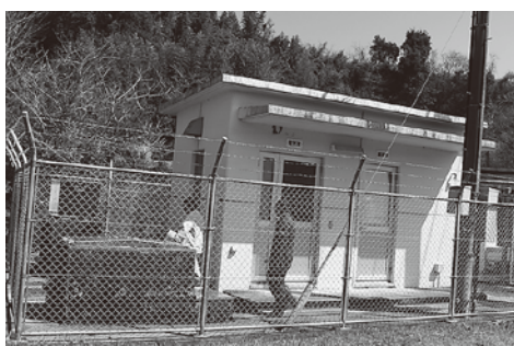
▲後川内浄水場2号取水井戸ポンプ交換工事
