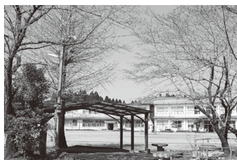
▲町道後川内保育所線他1路線配水管布設替工事場所
