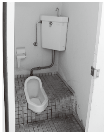
▲高原小学校屋内運動場 トイレ改修工事
