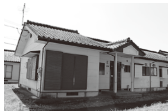
▲後川内団地7年棟外壁補修工事
