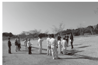
▲総合運動公園多目的芝生広場観覧席設置工事予定地
