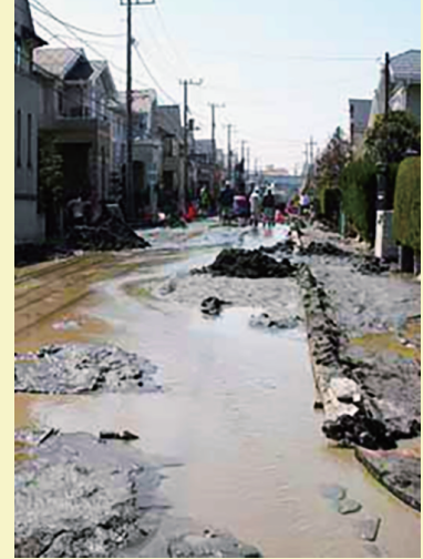
宅地の被害 出典：国土交通省ホームページ
