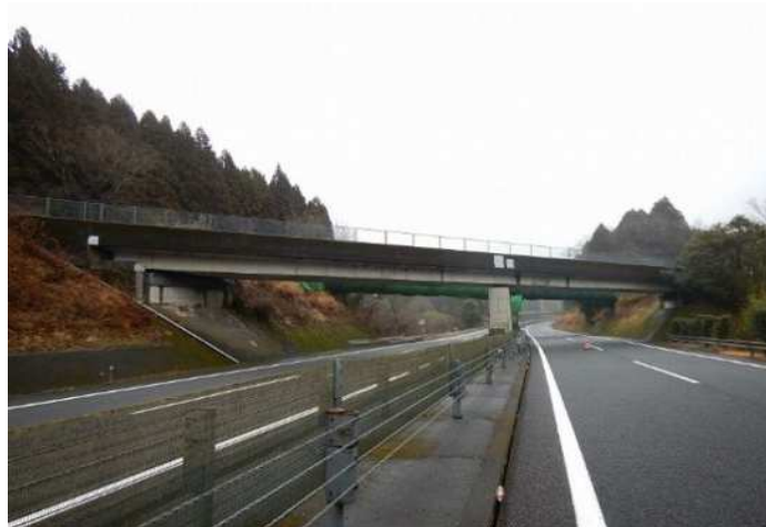
図 10 道路を跨ぐ橋梁の例（高原町管理 鳩取山橋）
